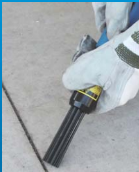
コンクリートの目荒らし
