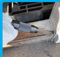
溶接スラグ落とし
